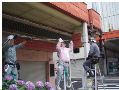
わらじまつり電源設置工事
