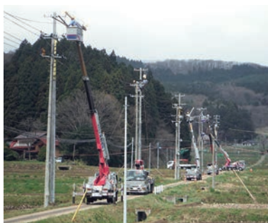
(株)東和電気による作業風景
