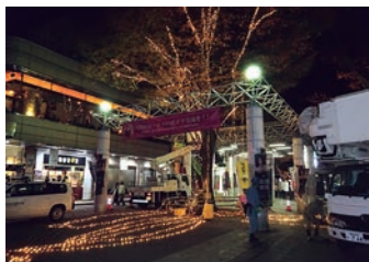
福島駅東口イルミネーション取付工事
