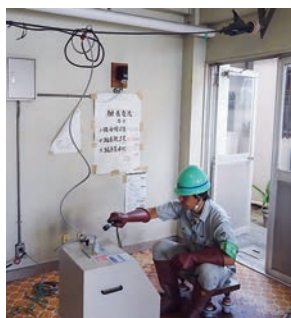
高電圧耐圧試験の様子
