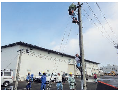
引込線工事技能訓練を受ける （有）晃電工社員
