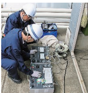
受変電設備の真空遮断機試験
