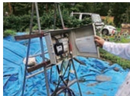
仮設電源盤を確認
